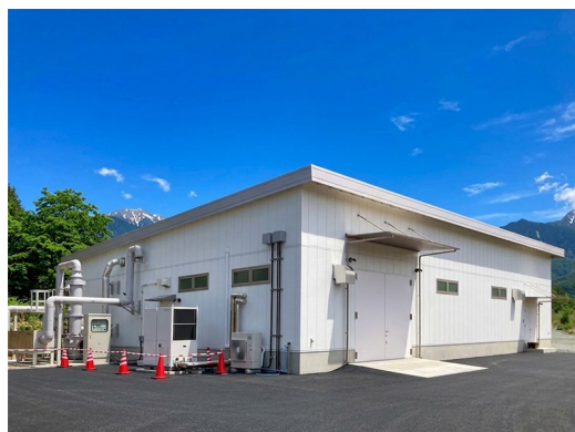
ケミトックス 北杜LiB試験センター
