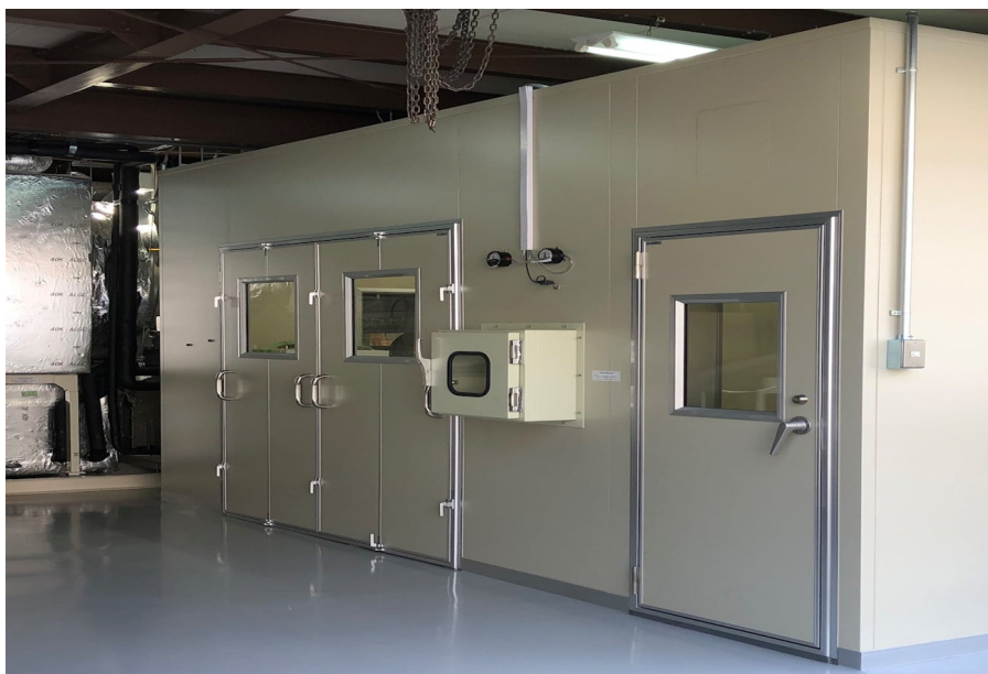
導入予定のドライルーム
