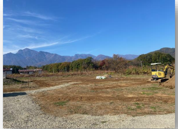
甲斐駒先端研究センター建設の様子
