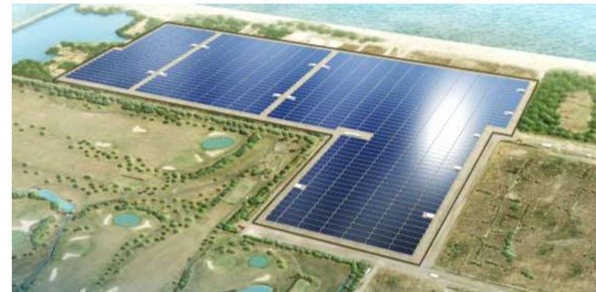
写真提供: 三井不動産株式会社
